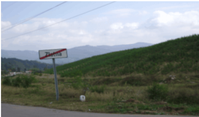
Fig. 7. Ecologizarea decantorului de steril prin înierbare
