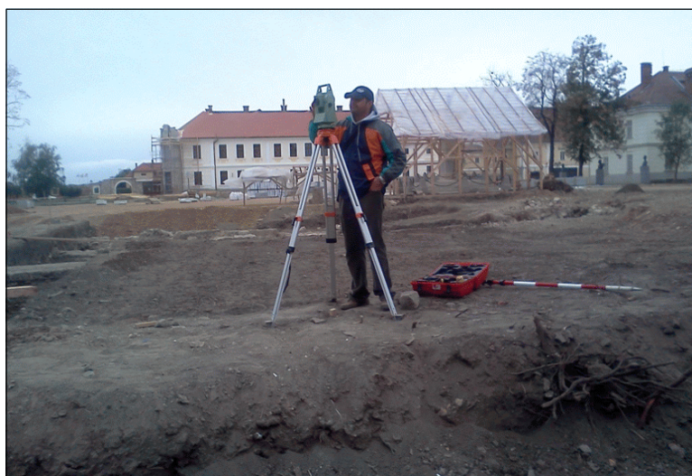
Fig. 2. Efectuarea măsurătorilor topografice
