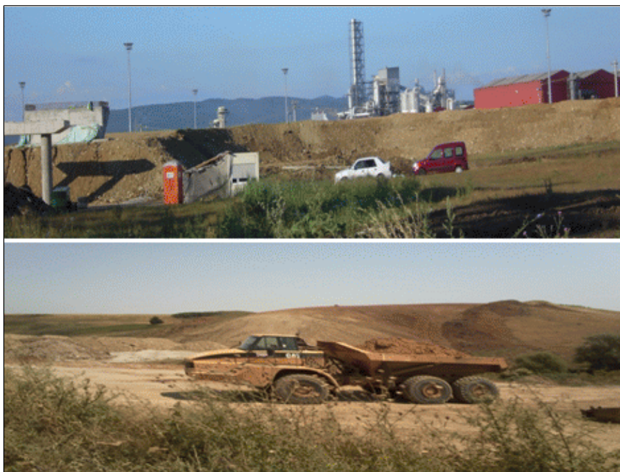
Fig. 8. Lucrări le autostrada Orăștie-Sibiu la Sebeș (sus) și Tărtăria (jos)
