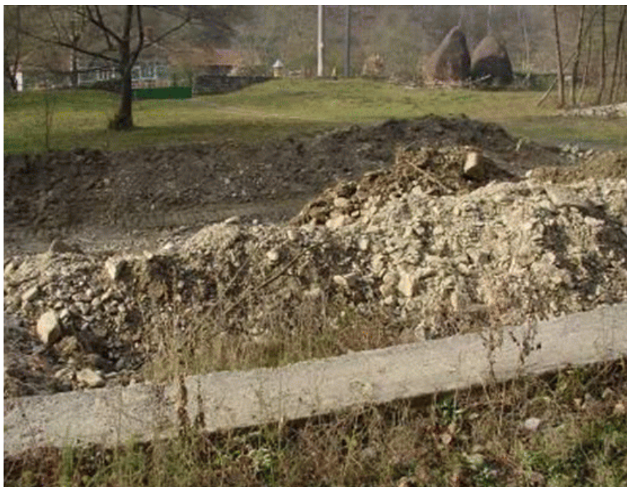
Fig. 12. Lucrări hidrotehnice în municipiul Sebeș pentru reducerea nivelului apei subterane
