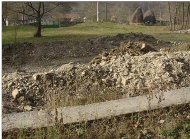
Fig. 11. Lucrări de regularizare ale pâraului Băcăinți (Sursa: Plan de amenajare a teritoriului județean Alba, 2009)
